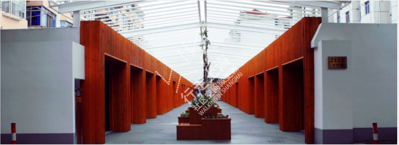
改造后街巷入口
