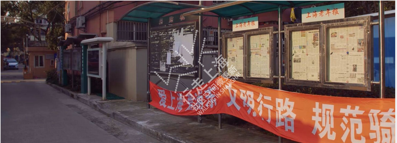
改造前入口附近
