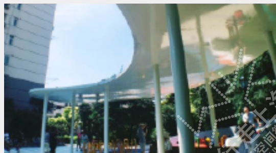
改造后水泵房
