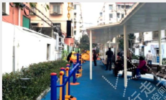
改造后建设设施
