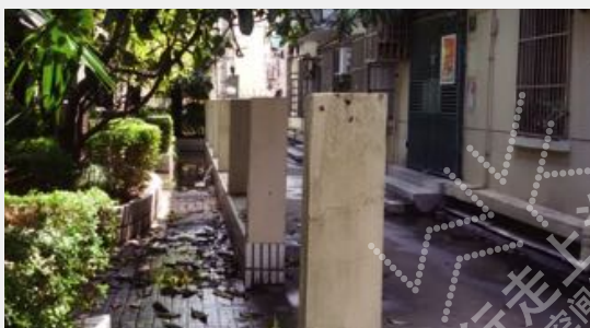
改造前走廊处
