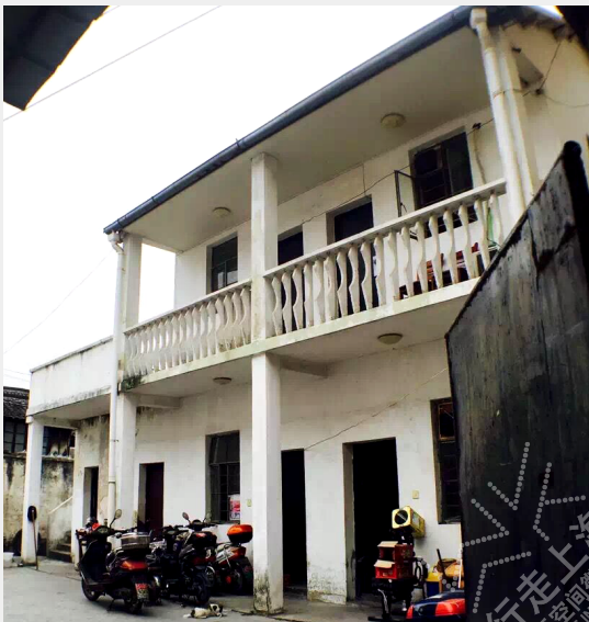
改造前活动室楼
